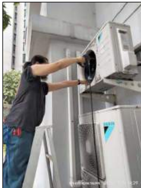
รูปที่ 62 การล้างเครื่องปรับอากาศพื้นที่ส่วนกลางของโครงการ
