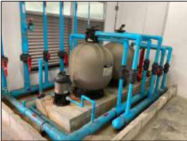
รูปที่ 32 ห้องควบคุมระบบกรองสระว่ายน้ำและพื้นที่จัดคลอรีน
