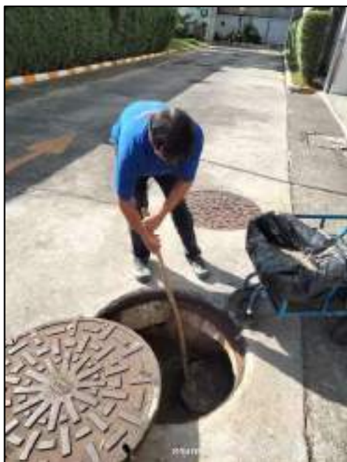
รูปที่ 51 การตักไขมันของโครงการ
