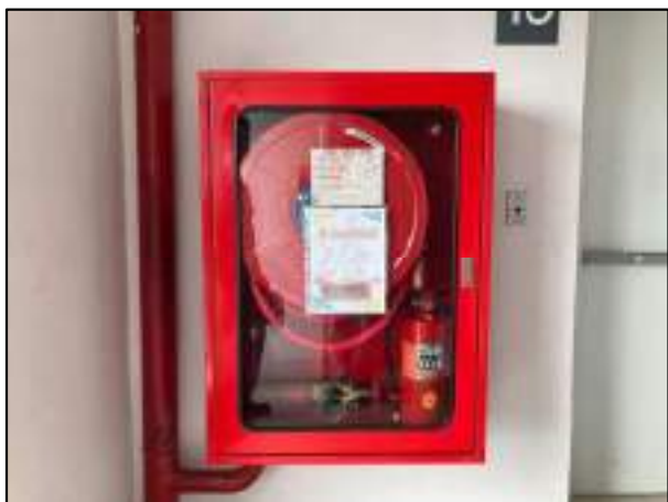
ตู้ดับเพลิง ตู้สายฉีดน้ำดับเพลิง
