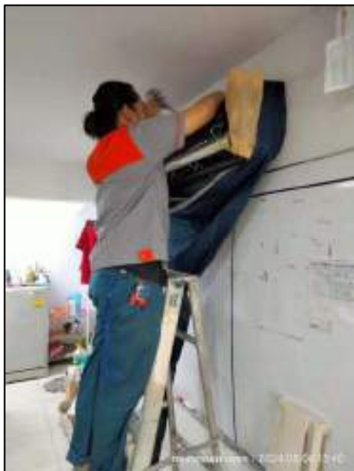
รูปที่ 62 การล้างเครื่องปรับอากาศพื้นที่ส่วนกลางของโครงการ
