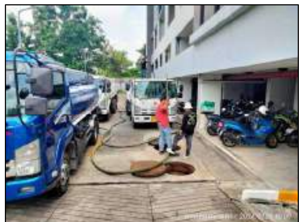
รูปที่ 50 การสูบลากตะกอนของโครงการ
