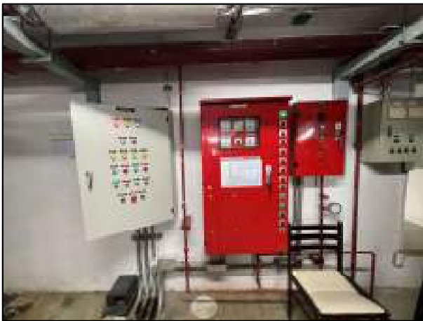
ตู้ควบคุมระบบ Fire pump
